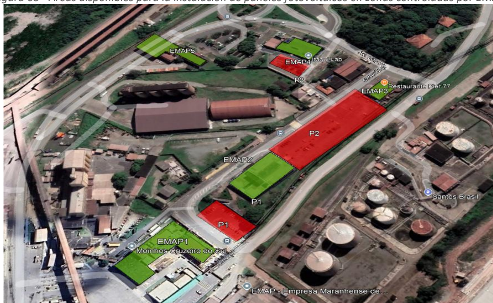
Figura 63 - Áreas disponibles para la instalación de paneles fotovoltaicos en zonas controladas por EMAP.
