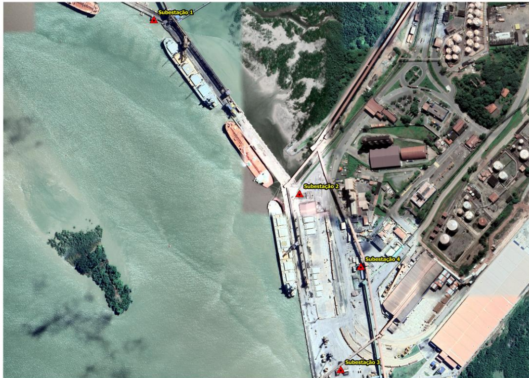
Figura 4 - Ubicación de las subestaciones eléctricas dentro del puerto.
