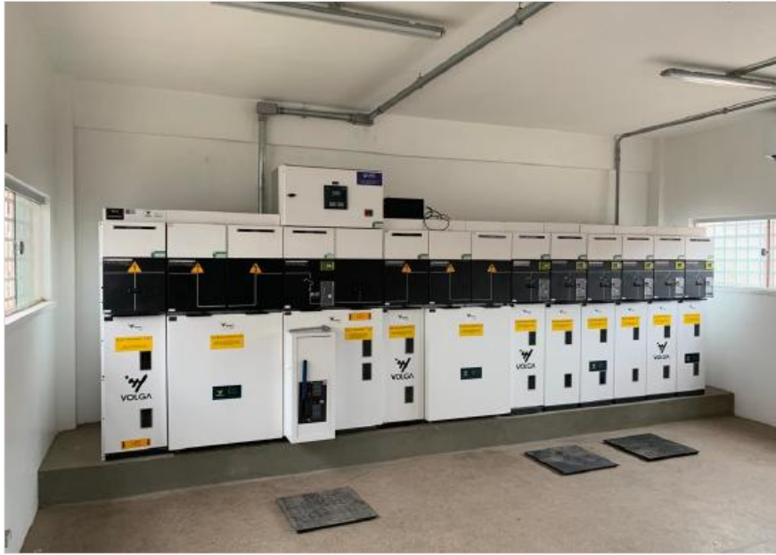
Figura 64 - Panel de media tensión de la EMAP [6]
