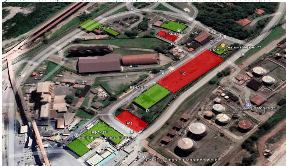
Figura 63 - Áreas disponíveis para instalação de painéis fotovoltaicos em zonas controladas pela EMAP.
