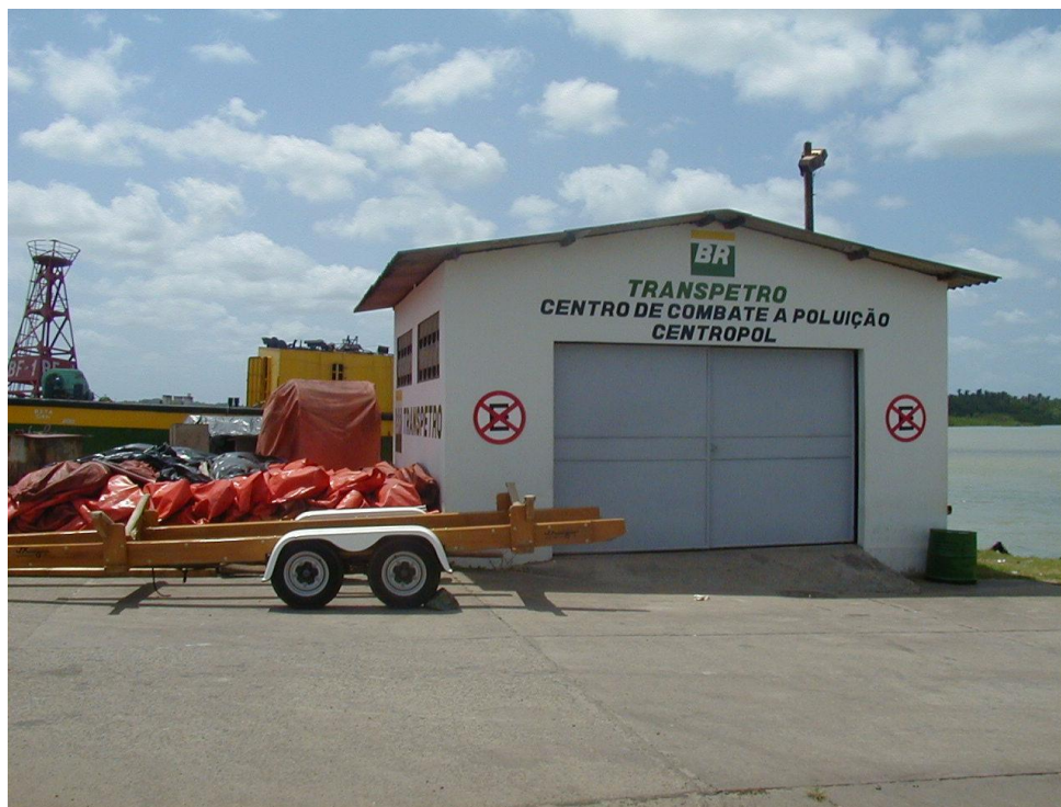
Figura 13: Vista das instalações do CENTROPOL da PETROBRÁS.
