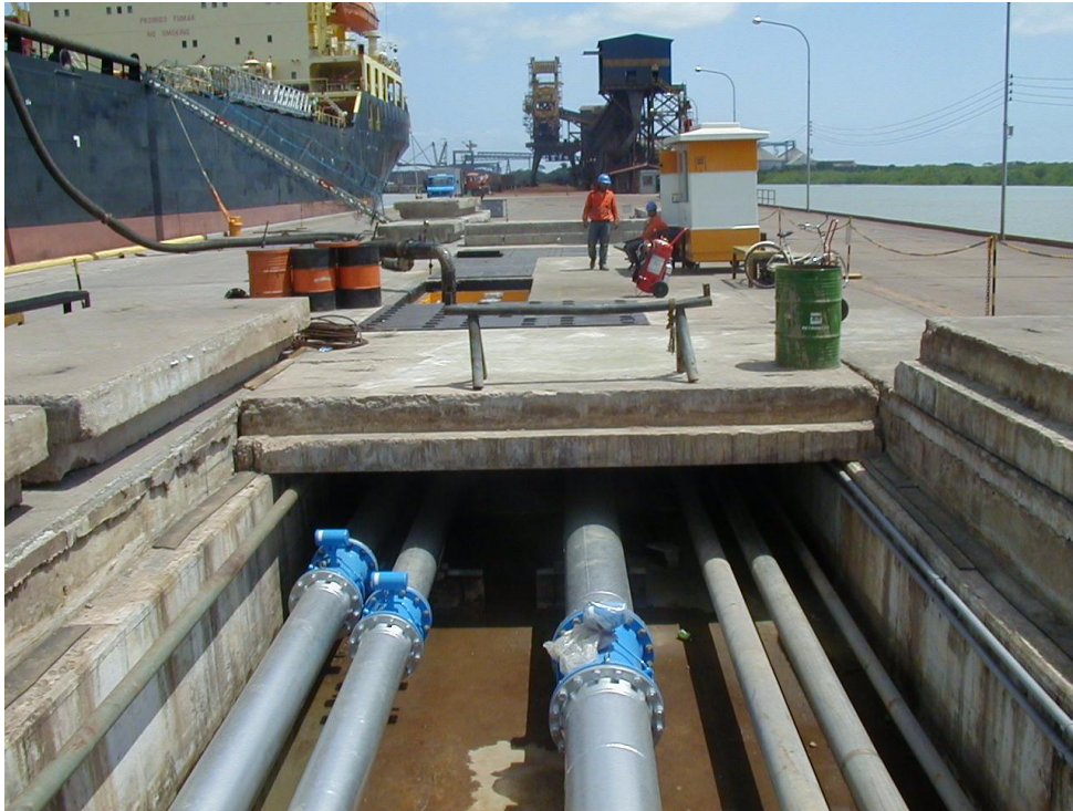
Figura 11: Detalhe da galeria de tubulações nos Berços 105 e 106.
