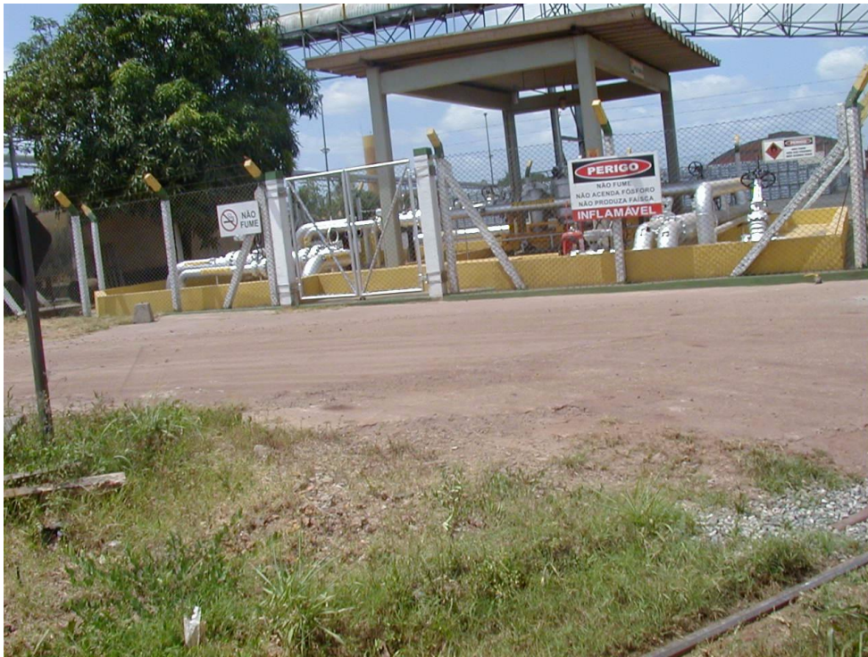
Figura 10: Vista das tubulações na área interna do Porto do Itaquí.
