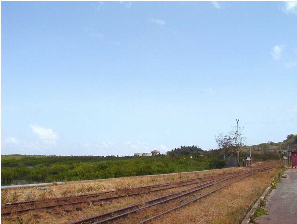
Figura 4: Detalhe das áreas internas do Porto, sujeitas a intervenções físicas, de ampliação das instalações.
