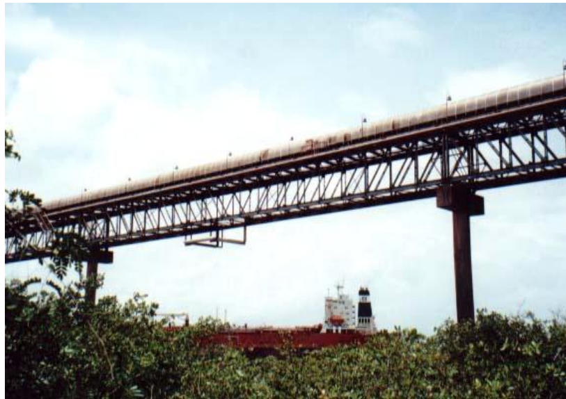
Figura 27 – Aspecto da esteira de carregamento de minérios, sobre o manguezal, na área do pier 2, CVRD
