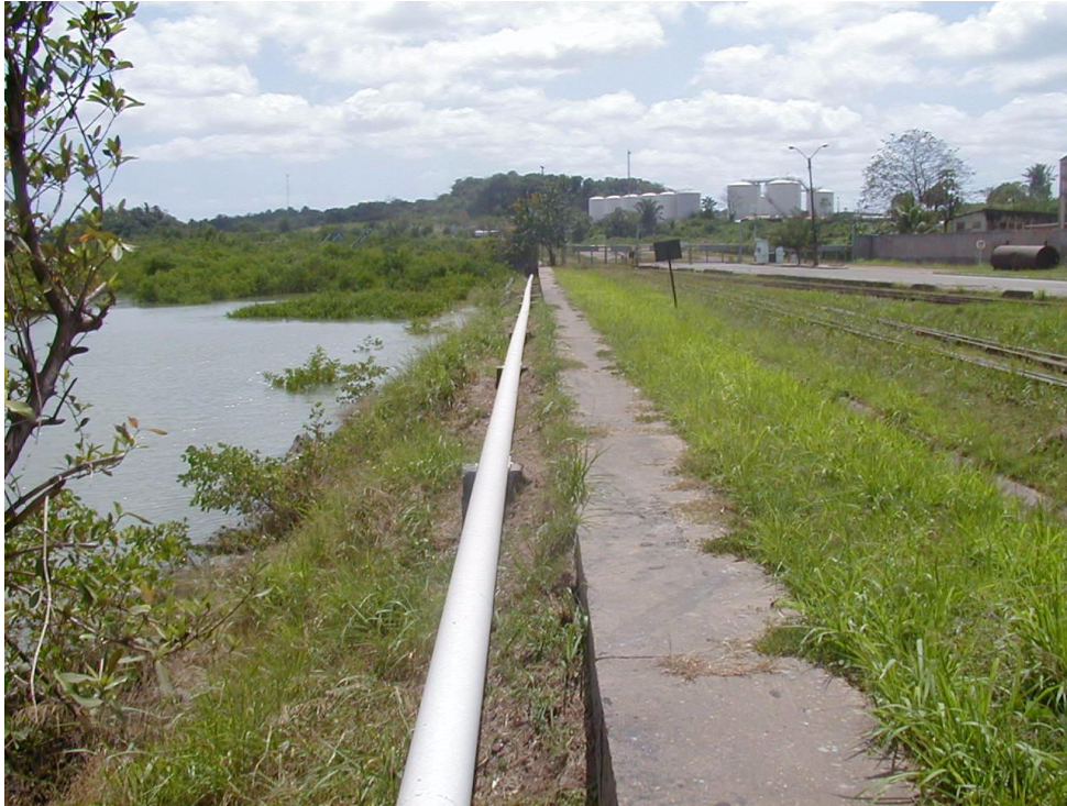
Figura 7: Aspecto da tubulação de granéis que interliga a Granel Química aos Berços 103 e 104.
