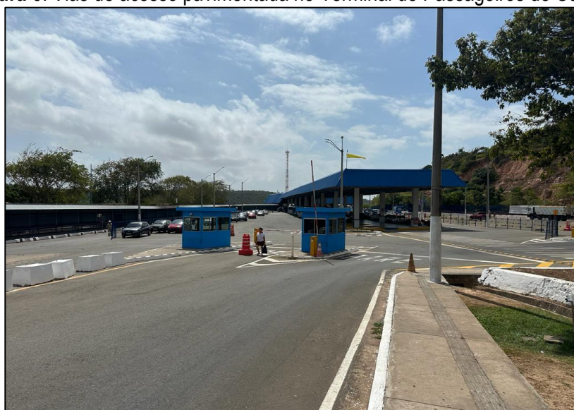
Figura 6: Vias de acesso pavimentada no Terminal de Passageiros de Cuijue
