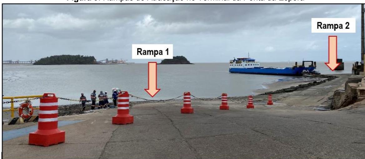
Figura 9: Rampas de Atracação no Terminal da Ponta da Espera
