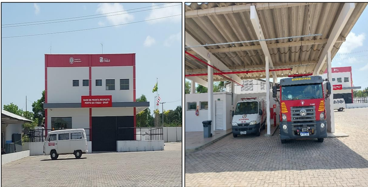
Figura 8: Prédio do Corpo de Bombeiros localizado na área do Terminal de Passageiros de Ponta da Espera
