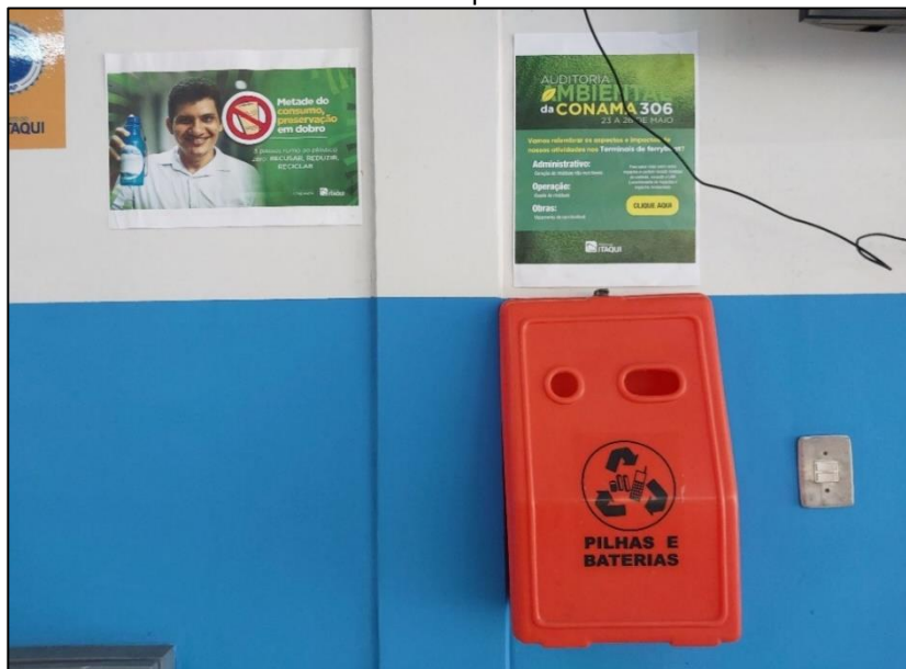
Figura 15: Coletores para resíduos perigosos (pilhas e baterias) disponibilizado no Terminal de Ponta da Espera
