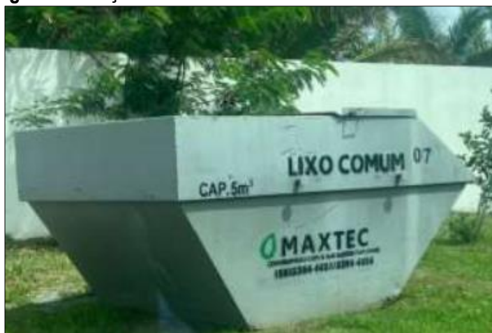
Figura 22: Caçambas de resíduos sólidos no canteiro de obras
