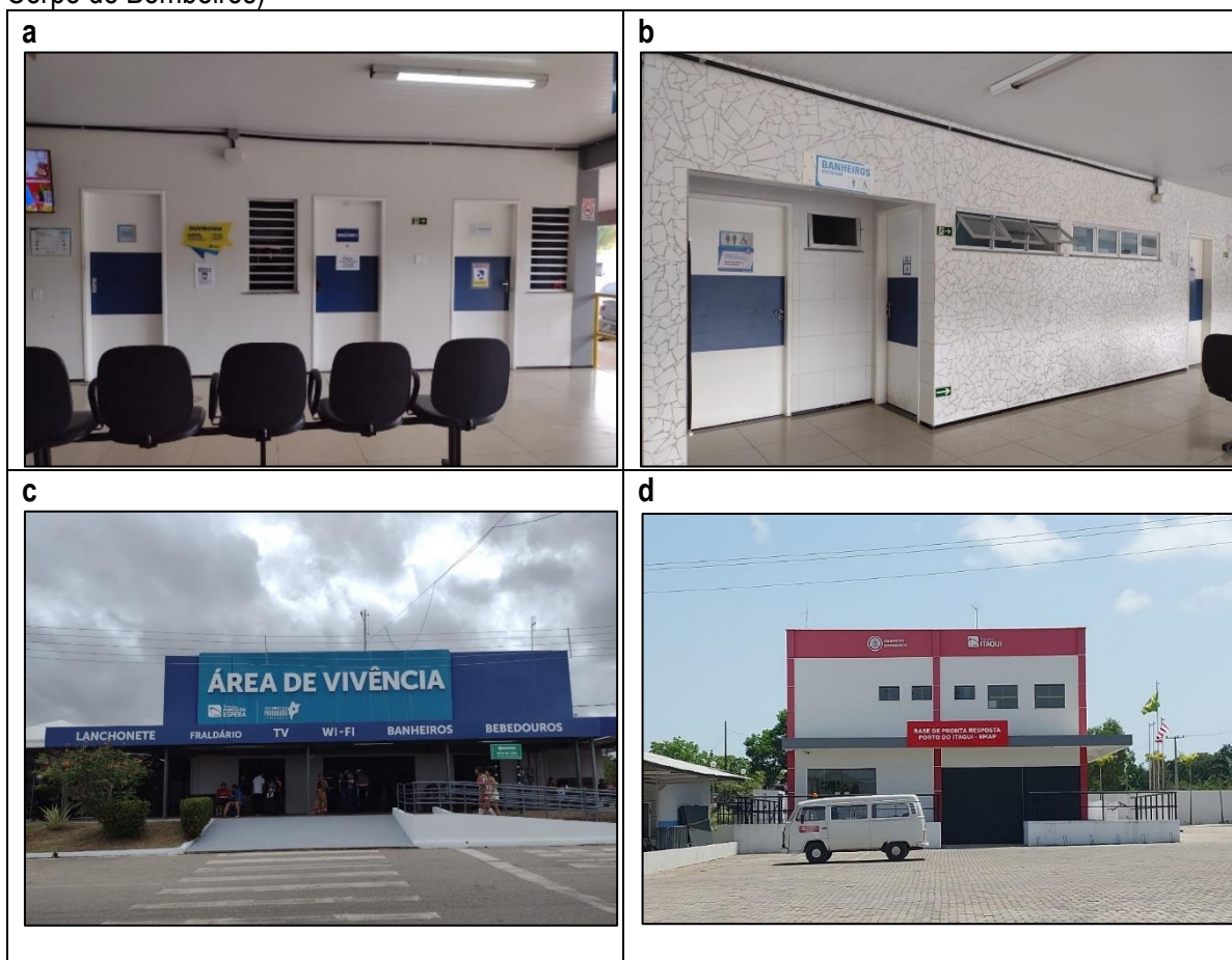
Figura 12: Exemplos de áreas de geração de resíduos existente no Terminal de Passageiros de Ponta da Espera ( a –Prédio administrativo; b - Banheiros fixos; c - Área de vivência; d – Prédio de Apoio do Corpo de Bombeiros)
