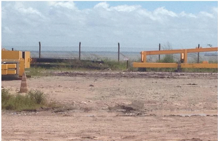
Figura 11A – Vista para o canal da Estação Remota 3 Fonte: EMAP (2015)
