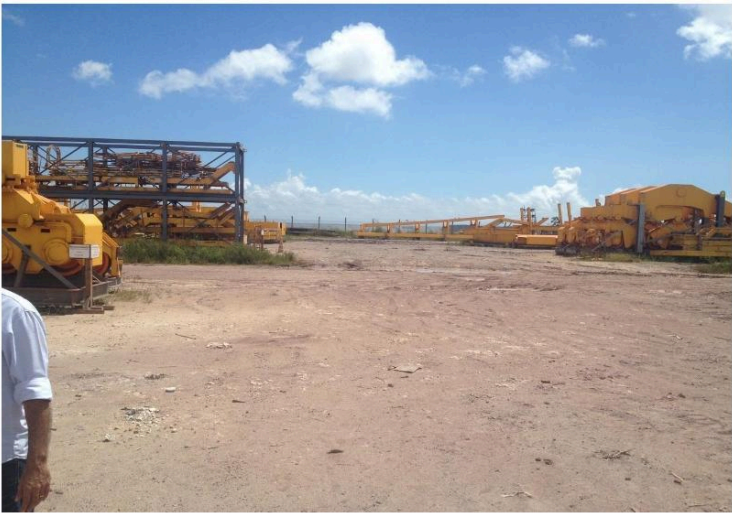
Figura 11 – Local de instalação em área próxima à Subestação da CEMAR
