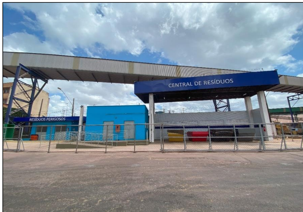
Figura 19: Central de Resíduos existente no Porto Organizado do Itaqui.
