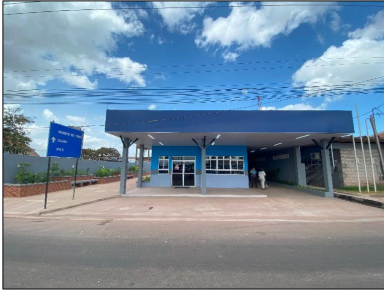
Figura 32: Área de geração de resíduos de serviço de saúde existente no prédio da COMED.
