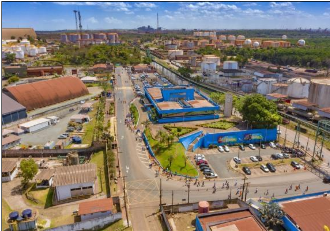
Figura 3: Vista aérea da área administrativa do Porto Organizado do Itaqui.
