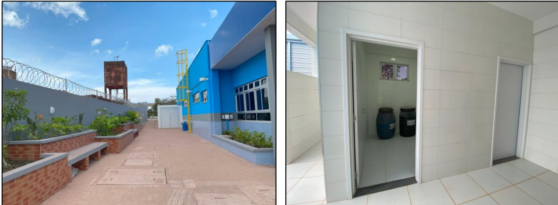
Figura 37: Abrigo de Resíduos de Serviço de Saúde, com recipientes para armazenamento de resíduos infectantes.
