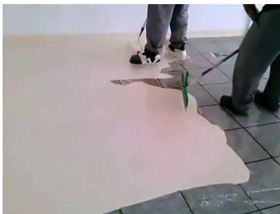
Figura 02: aplicação da massa autonivelante
