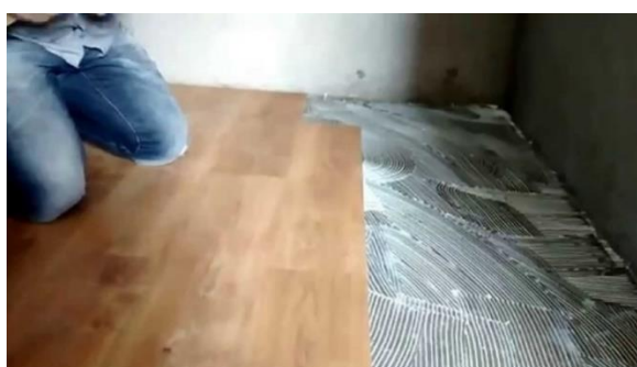
Figura 03: aplicação de cola para piso vinílico
