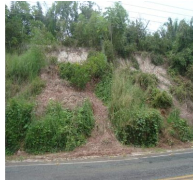
Feições de escorregamento na unidade argilosa
