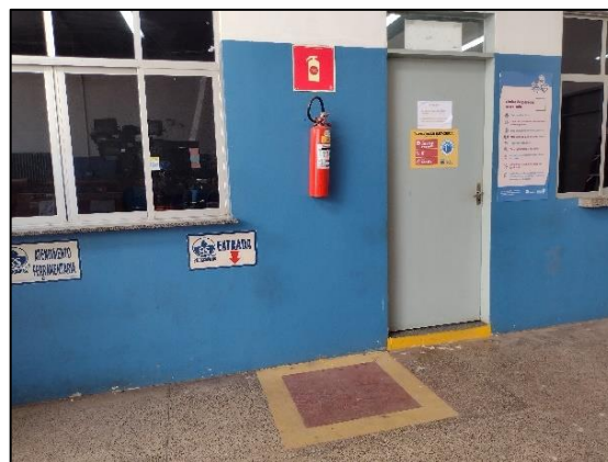
Figura 14: Extintor de incêndio na área da oficina, no Porto Organizado do Itaqui.
