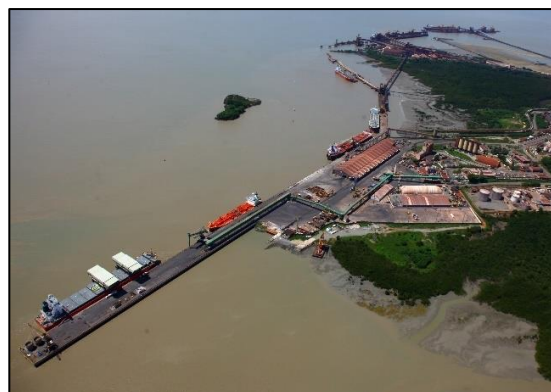
Figura 3: Vista aérea dos Berços localizados no Porto Organizado do Itaqui. Fonte: Agregar Ambiental, 2022.
