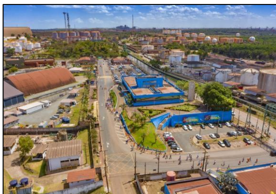
Figura 2: Vista aérea da área administrativa do Porto Organizado do Itaqui. Fonte: Agregar Ambiental, 2022.
