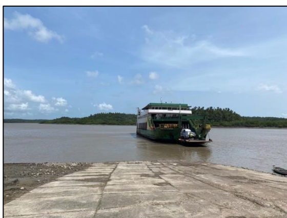
Figura 5: Rampa de embarque/desembarque do Terminal de Passageiros de Cuijue.
