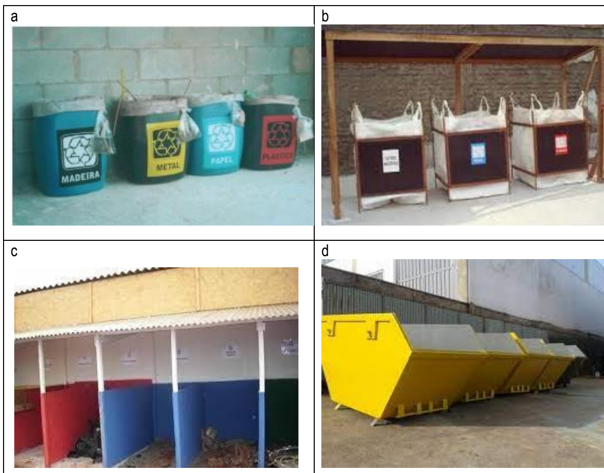
Figura 25: Modelos de dispositivos de armazenamento para acondicionamento de resíduos de construção civil (a- bombonas; b- bag; c- baias; d- caçambas estacionárias).
