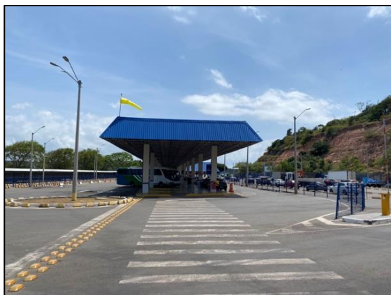
Figura 9: Vias de acesso pavimentada no Terminal de Passageiros de Cujupe. Fonte: Agregar Ambiental, 2022.
