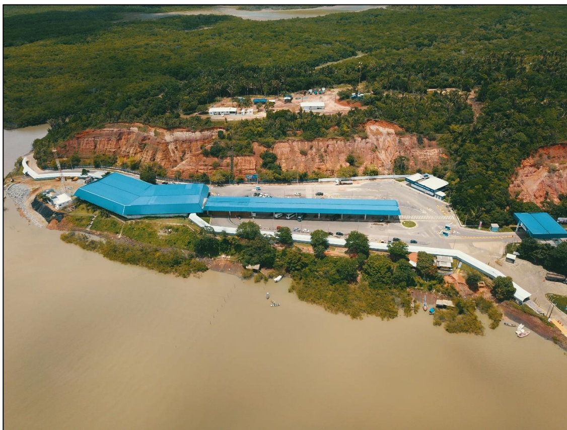
Figura 2: Vista geral do Terminal de passageiros da do Cujupe. Fonte: Agregar Ambiental, 2023.
