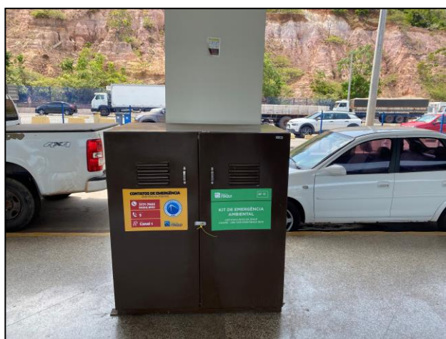
Figura 28: Kit de emergência no Terminal de Passageiros de Cajupe. Fonte: Agregar Ambiental, 2021.
