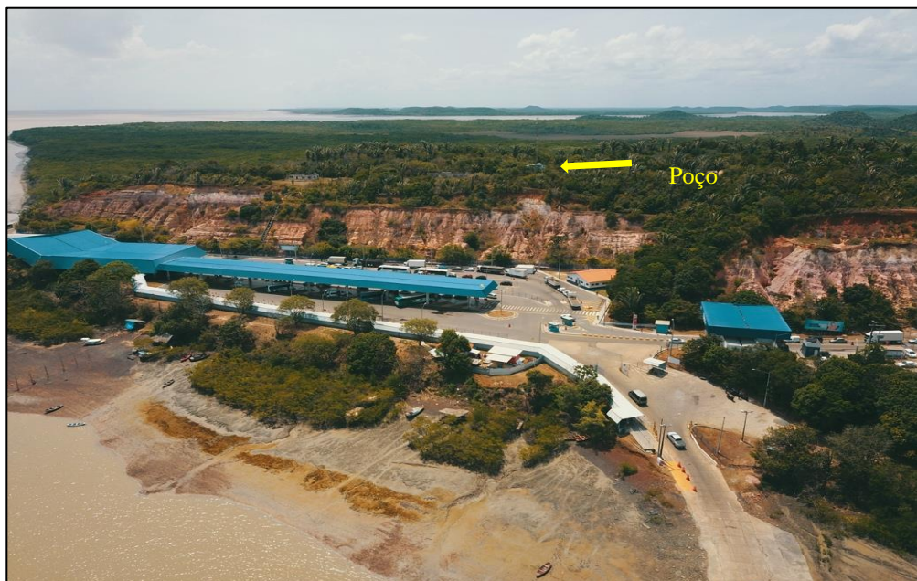
Figura 12: Poço artesiano que atende o empreendimento em estudo. Fonte: Agregar Ambiental, 2021.
