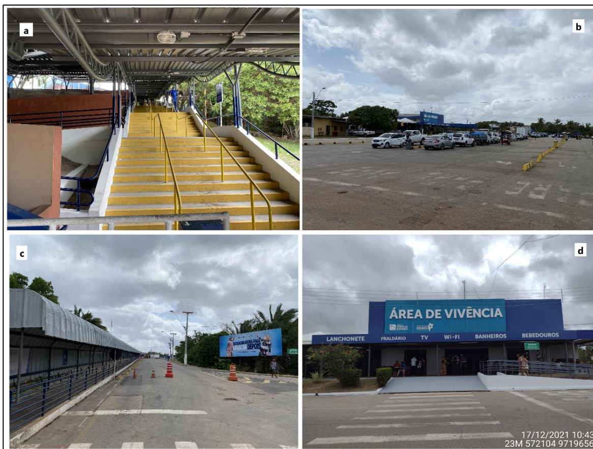
Figura 6: 6a: Estrutura física do terminal; 6b: Estacionamento; 6c: Local destinado a filas de veículos para embarque; 6d: Área de vivência e alimentação do terminal de Ponta da Espera.
