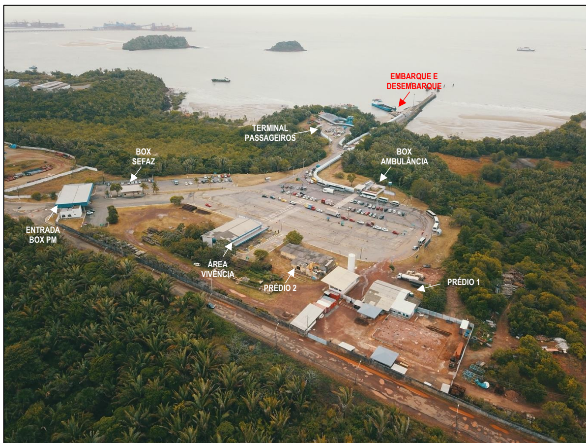
Figura 2: Vista geral do Terminal de passageiros da Ponta da Espera.
