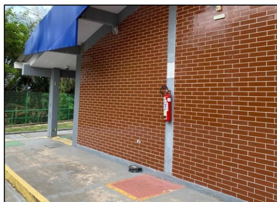
Figura 19: Extintor de incêndio na área do terminal de passageiros.
