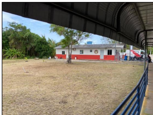
Figura 16: Caixa d’água do Box do Bombeiro do estabelecimento.
