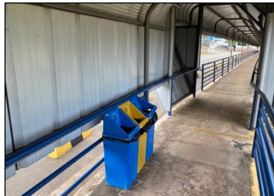
Figura 22: Depósitos de coleta seletiva da rampa de acesso ao Ferryboat do Terminal da Ponta da Espera.
