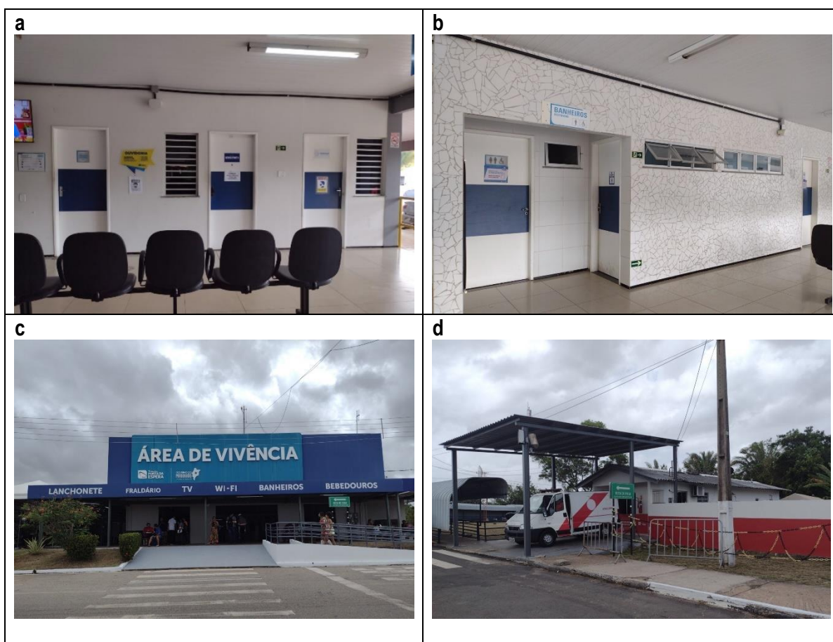
Figura 25: Exemplos de áreas de geração de resíduos existente no Terminal de Passageiros de Ponta da Espera (a – Prédio administrativo; b- Banheiros fixos; c - Área de vivência; d – Prédio de Apoio dos Bombeiros). Fonte: Agregar Ambiental, 2022.
