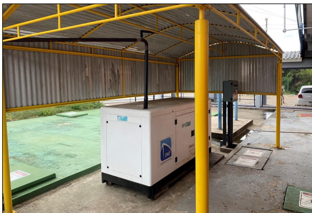
Figura 14: Gerador de energia elétrica existente no empreendimento para uso em período de falta de energia. Fonte: Agregar Ambiental, 2021.
