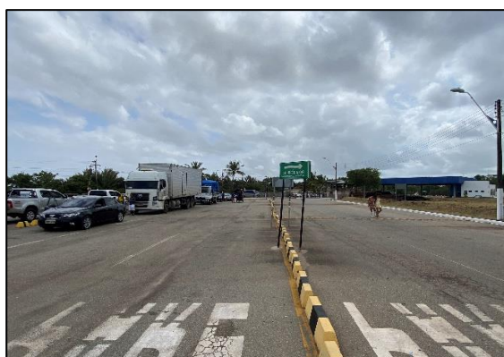
Figura 11: Vias de acesso pavimentadas no interior do empreendimento. Fonte: Agregar Ambiental, 2021.
