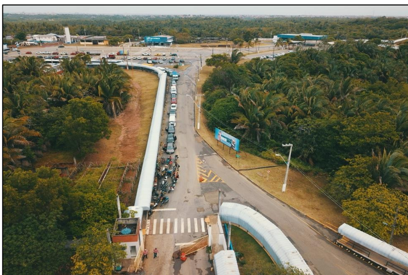
Figura 9: Vias de acesso pavimentadas no interior do empreendimento.
