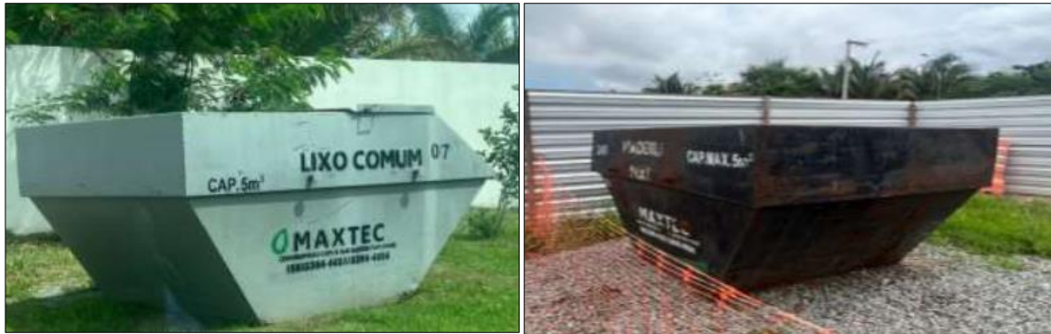
Figura 32 – Caçambas de resíduos sólidos no canteiro de obras da empresa Santa Cruz Engenharia. Fonte: Santa Cruz Engenharia, 2023.
