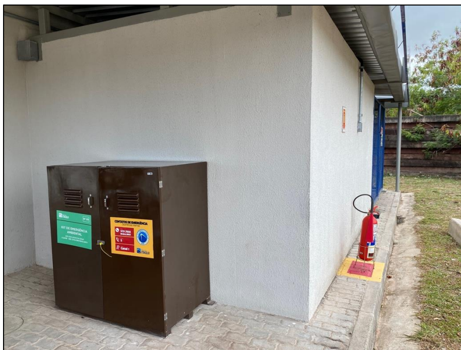
Figura 20: Kit de emergência ambiental e extintor de incêndio da área de vivência do Terminal da Ponta da Espera.
