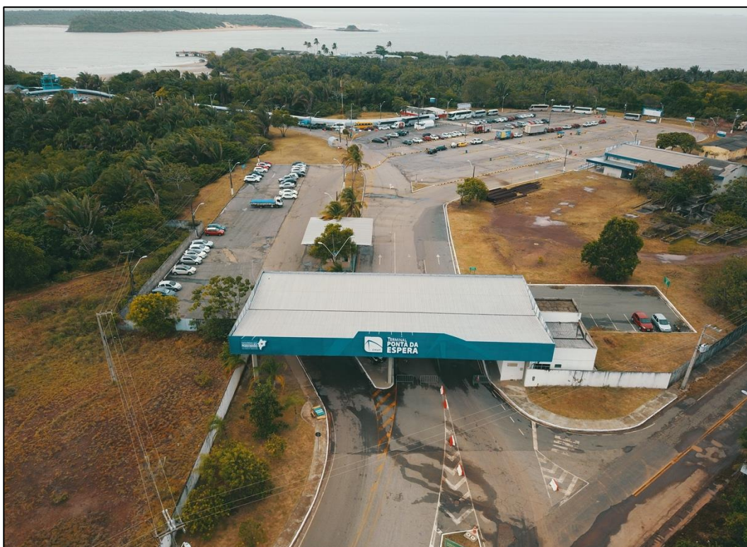
Figura 3: Vista geral do Terminal de passageiros da Ponta da Espera. Fonte: Agregar Ambiental, 2021.
