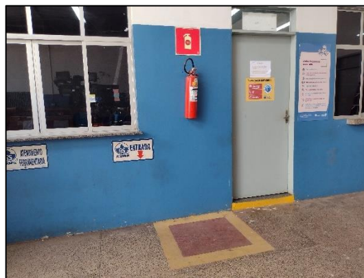
Figura 14: Extintor de incêndio na área da oficina, no Porto do Itaqui.
