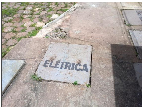
Figura 9: Rede elétrica trifásica que atende o empreendimento em estudo.
