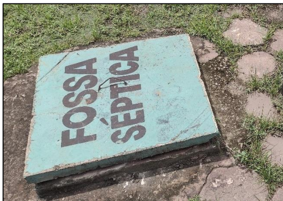
Figura 11: Área de acesso a fossa séptica no Porto do Itaqui.
