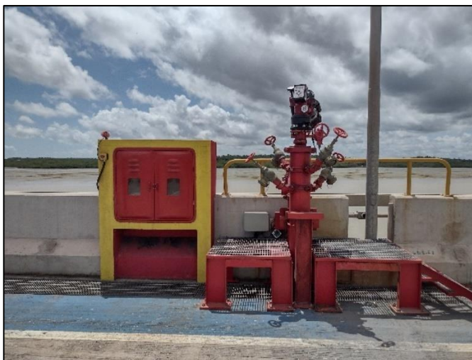
Figura 15: Estrutura de combate a incêndio na área dos Berços, no Porto do Itaqui. Fonte: Agregar Ambiental, 2022.
