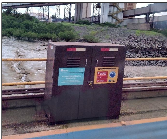
Figura 16: Kit de emergência ambiental da área dos Berços, no Porto do Itaqui. Fonte: Agregar Ambiental, 2022.
