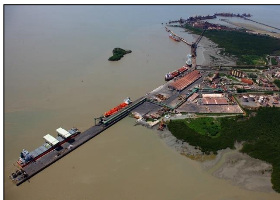
Figura 3: Vista aérea dos Berços localizados no Porto do Itaqui.
