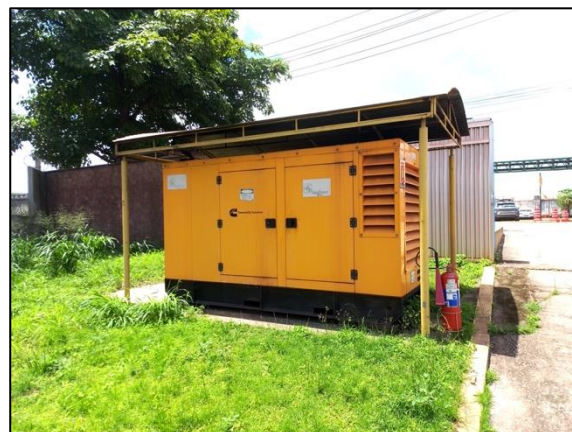
Figura 10: Gerador de energia elétrica existente no empreendimento para uso no caso interrupção do serviço.
