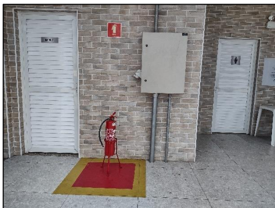
Figura 13: Extintor de incêndio na área dos Berços, no Porto do Itaqui.
