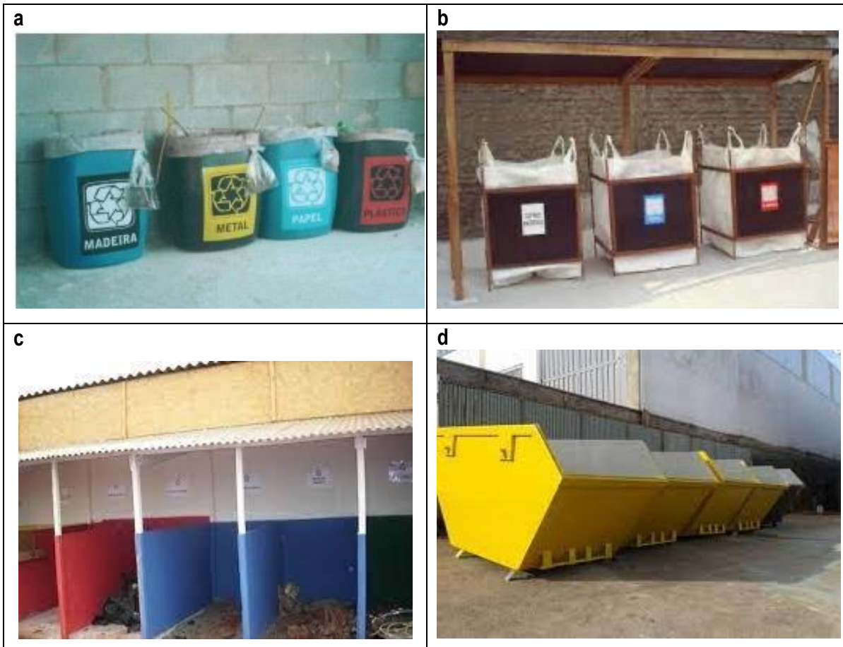
Figura 30: Modelos de dispositivos de armazenamento para acondicionamento de resíduos de construção civil (a- bombonas; b- bag; c- baias; d- caçambas estacionárias).
