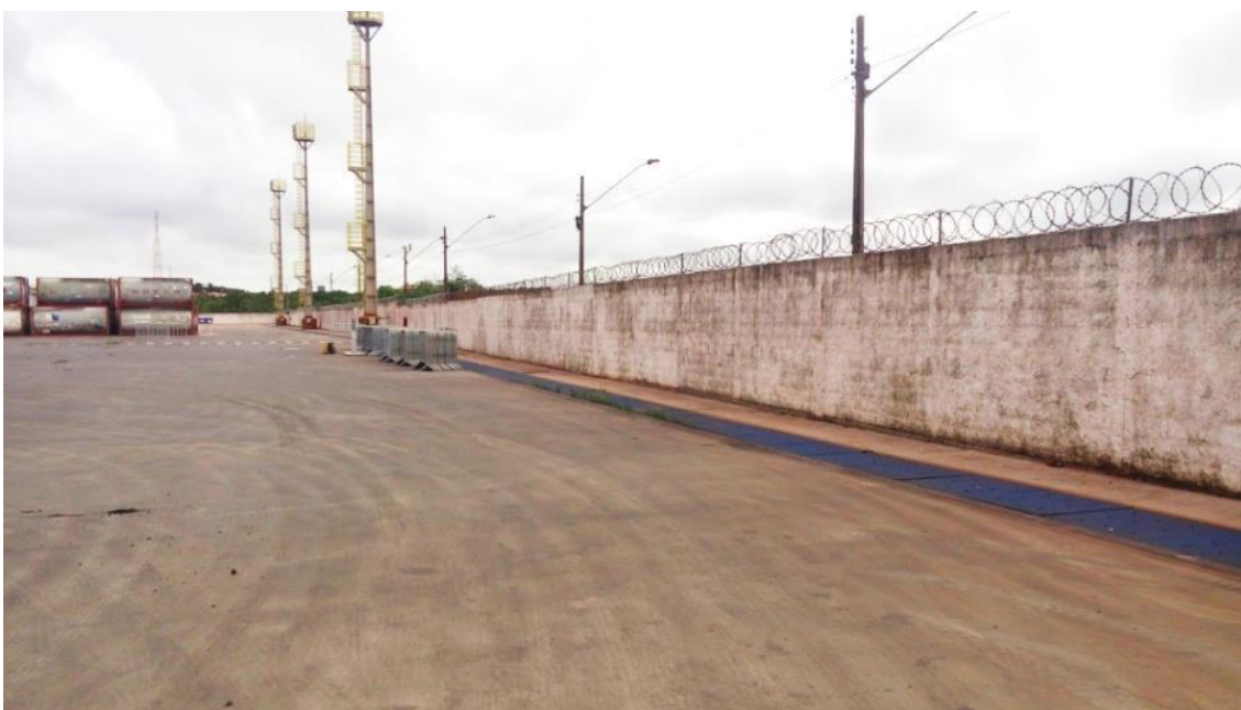
Figura 62 – Muro no Pátio H Fonte: Imagem fornecida pela EMAP (2019).
