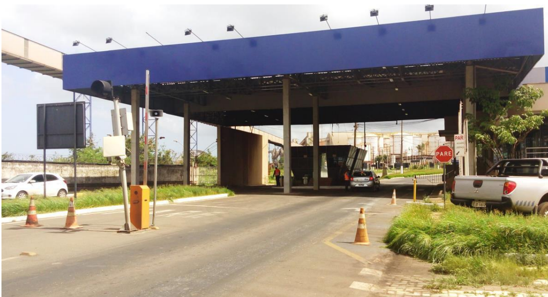
Figura 64 – Vista interna da Portaria de Acesso Norte (PAN) Fonte: Imagem fornecida pela EMAP (2019).
