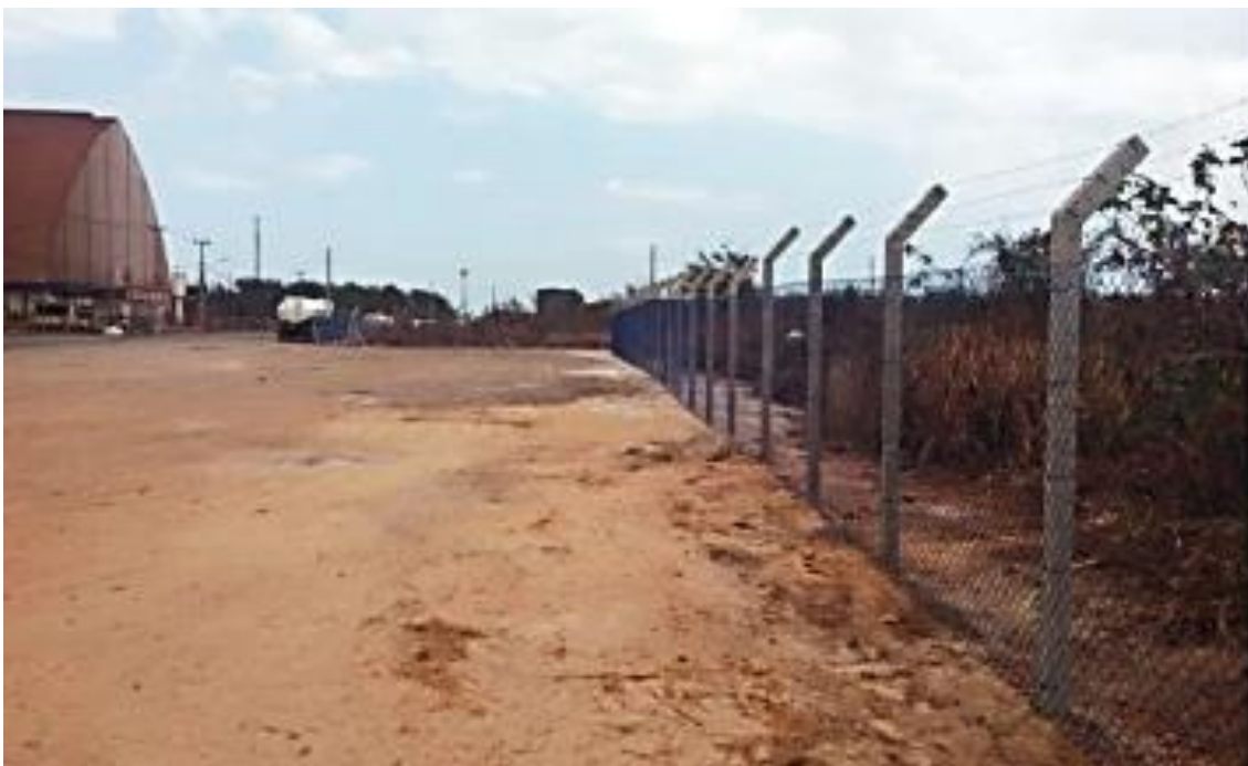
Figura 61 – Cerca na Área 02 Fonte: Imagem fornecida pela EMAP (2019).
