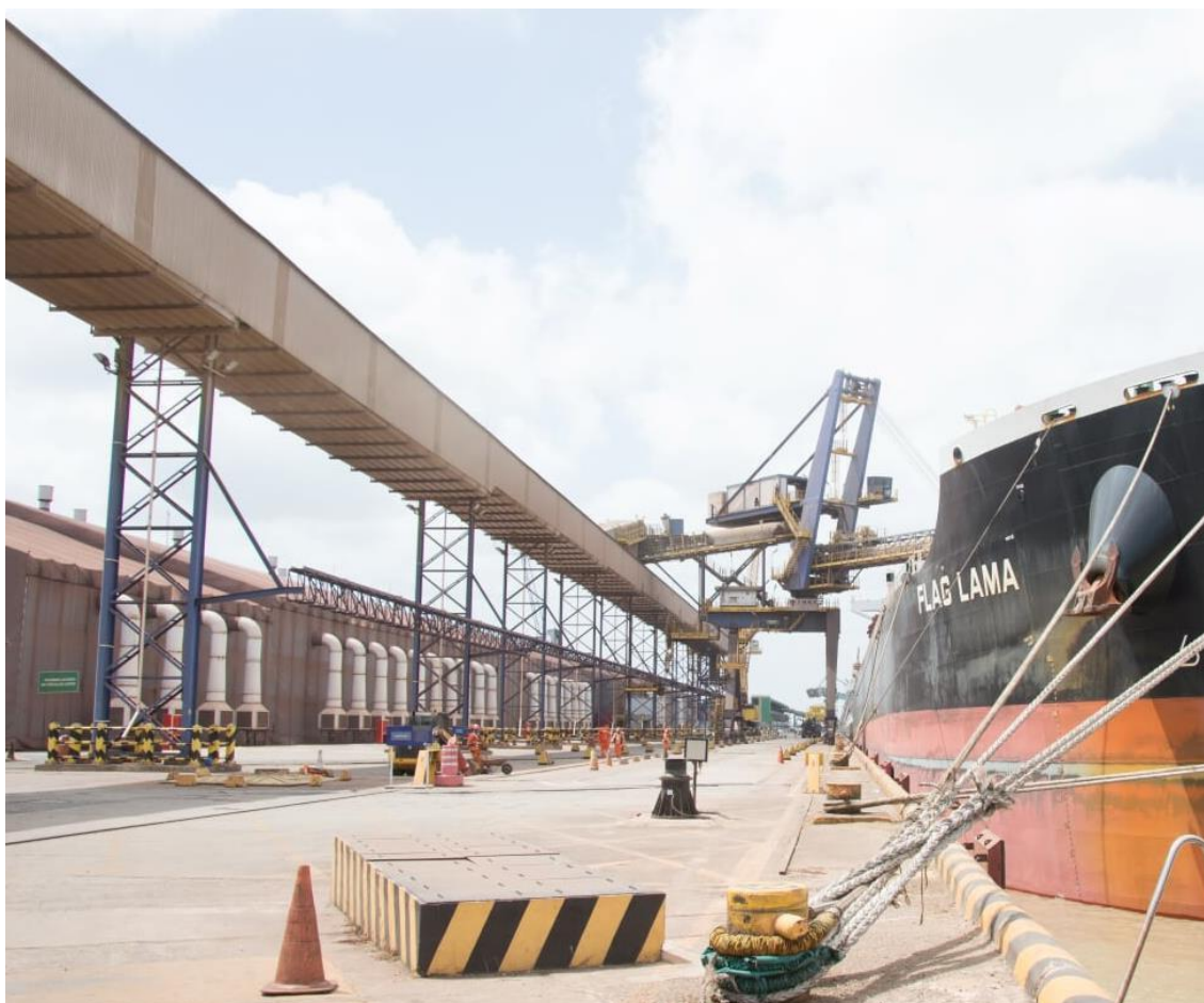
Figura 11 – Correia transportadora do Porto do Itaqui Fonte: Imagem obtida durante visita técnica (2018)
