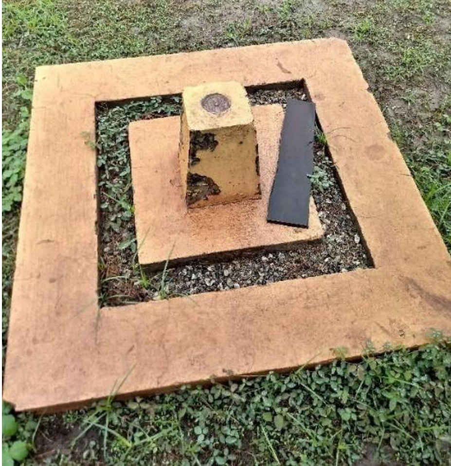
Figura 128 – Marco GPS implantado pelo IBGE no Porto do Itaqui Fonte: Imagem obtida durante visita técnica (2019).
