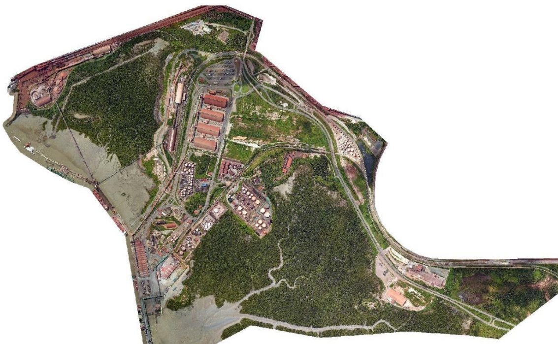
Figura 130 – Aerofoto proveniente de aerolevanteamento com VANT em 2015 Fonte: Imagem fornecida pela EMAP (2018).
