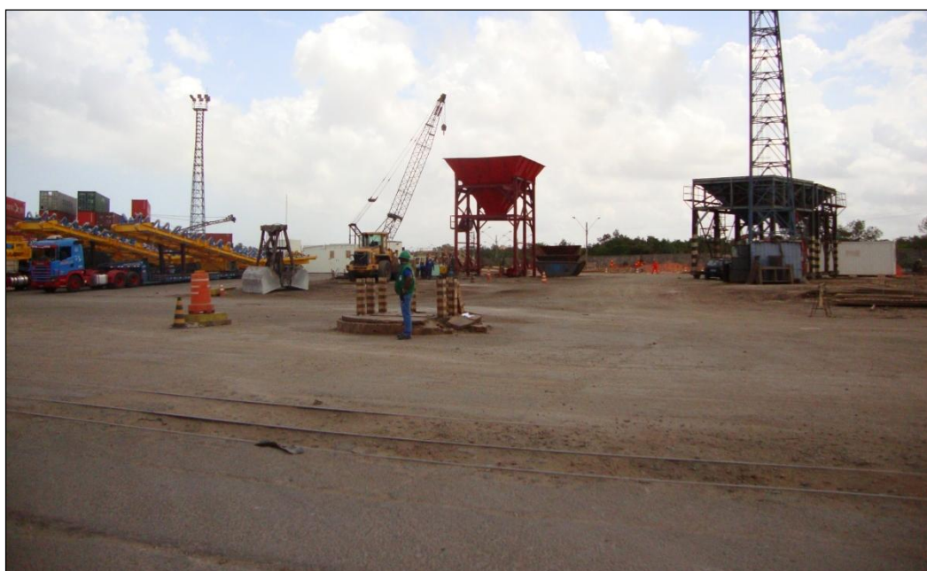
FIGURA 32 – CANTEIROS DE OBRAS ATRÁS DO BERÇO 101 (FOTO: 2010)
