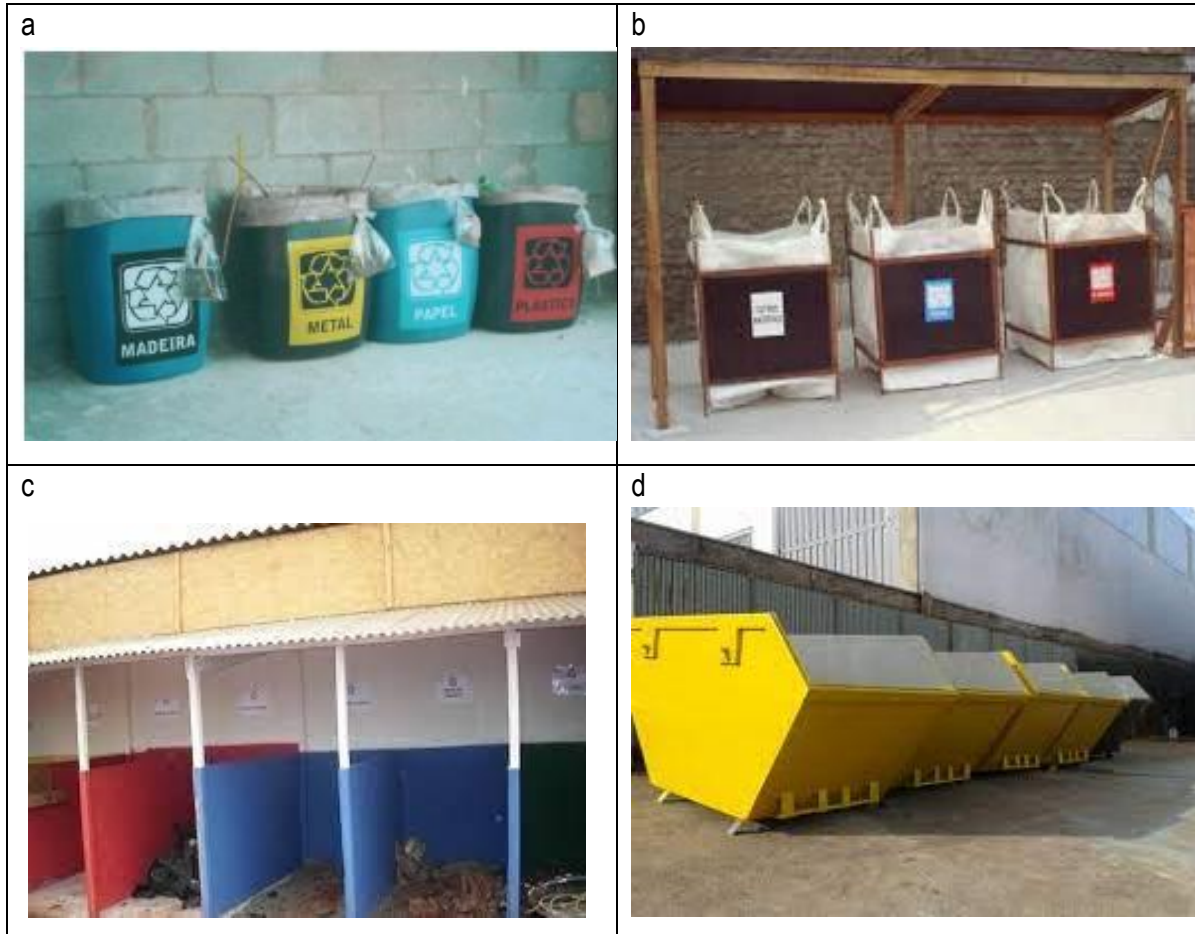
Figura 17 – Modelos de dispositivos de armazenamento para acondicionamento de resíduos de construção civil (a-bombonas; b-bag; c-baixas; d-caçambas estacionárias).
