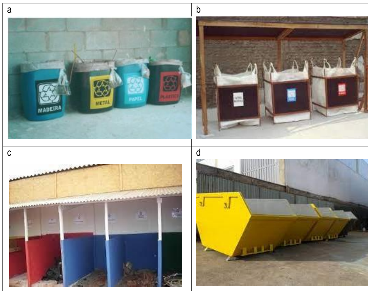
Figura 26 – Modelos de dispositivos de armazenamento para acondicionamento de resíduos de construção civil (a-bombonas; b-bag; c-baias; d-caçambas estacionárias).
