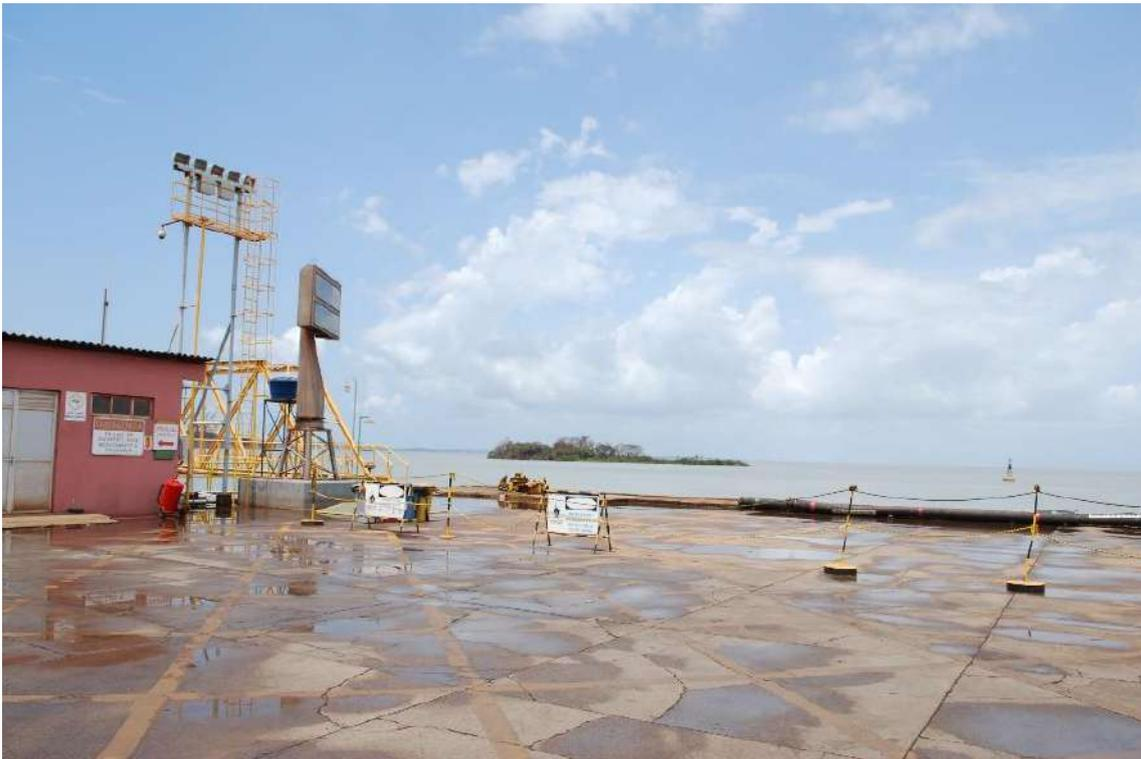
Figura 47 – Presença de fissuras e poças no pavimento rígido no interior do Cais Público
